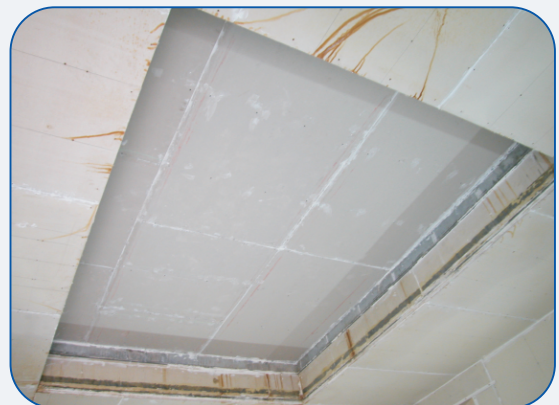
完成安装石膏板的缝填密封胶
