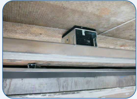
安装隔音悬置器连龙骨
