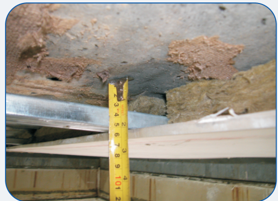
加装石膏板和吸音棉
